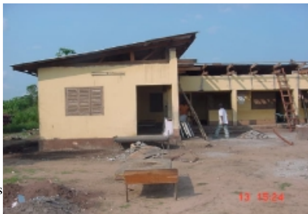
Réhabilitation du Centre de Santé Intégré d'Ongoni
