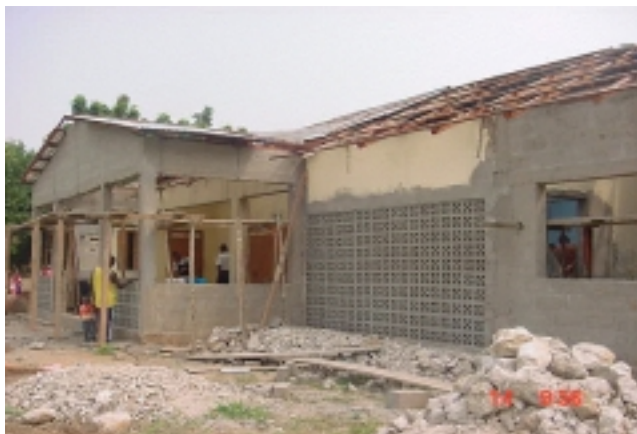
Réhabilitation du Centre de Santé Intégré d'Etoro
